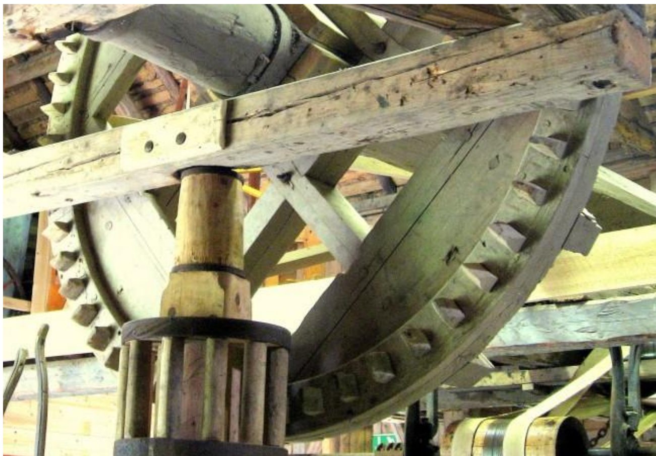
Kugghjulet med en diameter på 2,3 meter. Vid hästvandringen fördes kraften över till mangeln via en träaxel. Foto från 2006.
